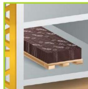
Фанеру, предназначенную для монтажа опалубки следующих этажей, аккуратно сложите в стопу для дальнейшего перемещения с помощью крана.
